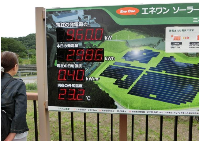
現在の発電状況が見れる掲示板
