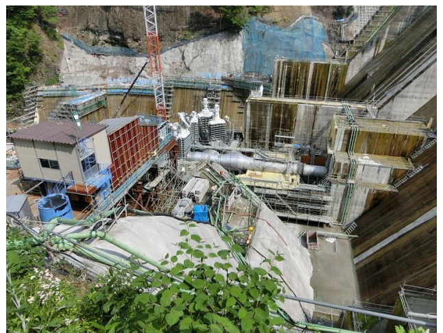
下流部で建設中の発電所
