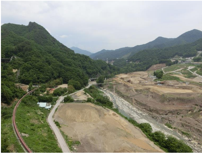
碎石運搬用のベルトコンベアがダムまで延る
