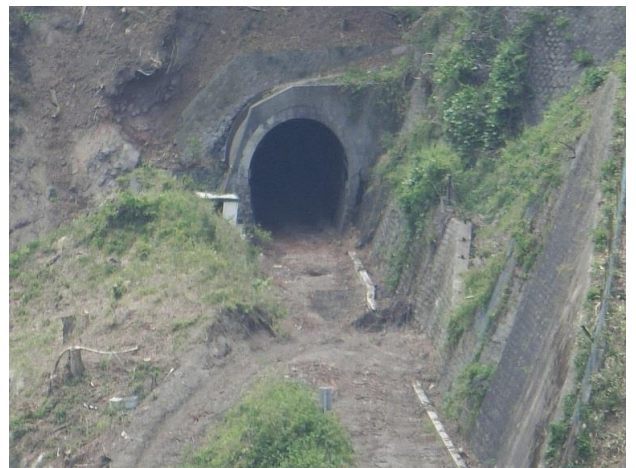
線路を撤去しトンネルだけが残る
