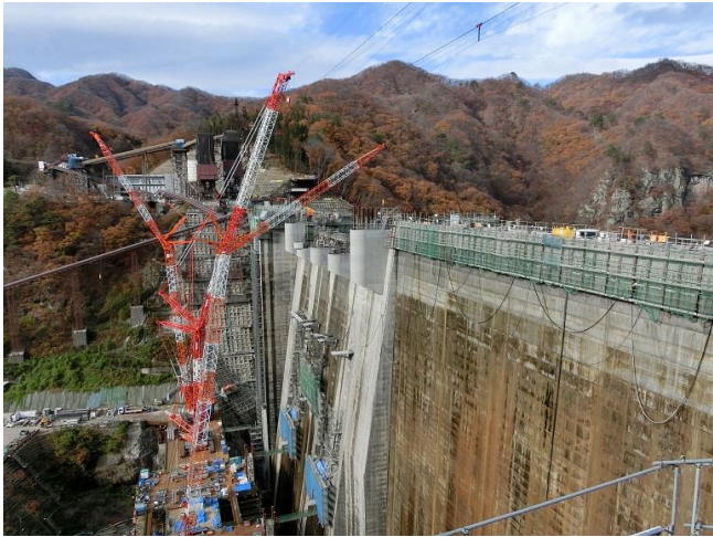
上流部左岸より残すは約10m
