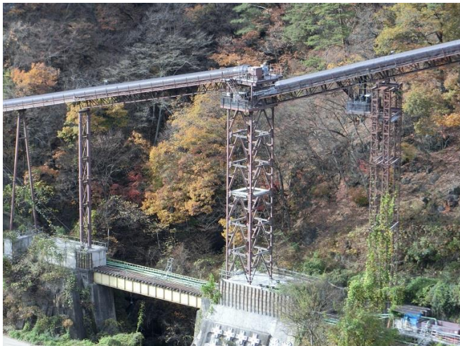
碎石を運搬するベルトコンベア10km
