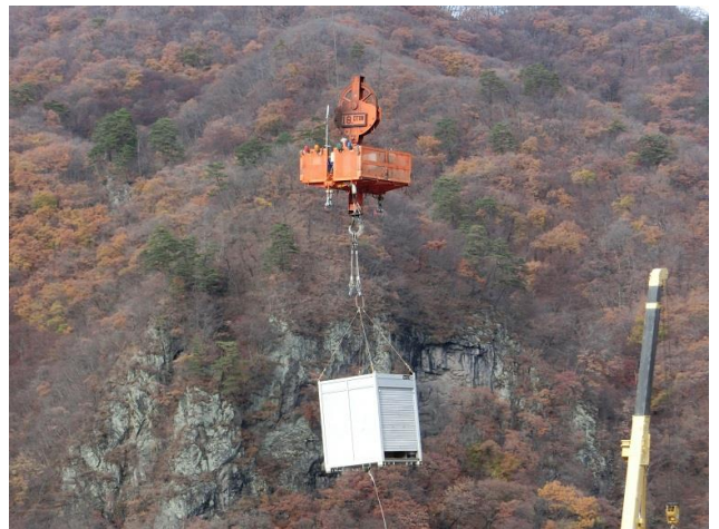
18トンクレーン
