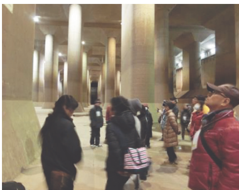
地下調圧水槽
